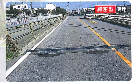
■ 橋のジョイント部
