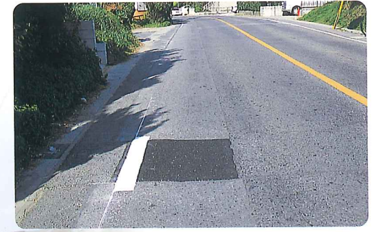
■ 水道・ガス・電話・小規模工事等の復旧
