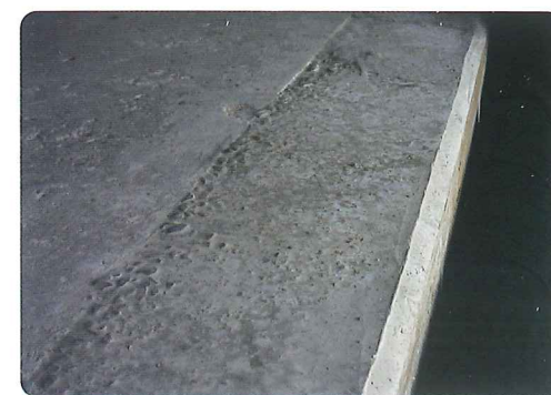
■ 配送用プラットフォーム部補修
