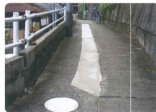
■ 歩道部段差補修
