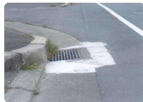
■ 集水桝復旧補修
