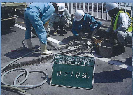
2 既設ジョイント撤去
