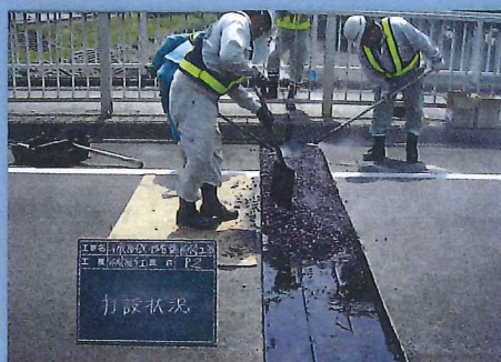
5 特殊合材打設
