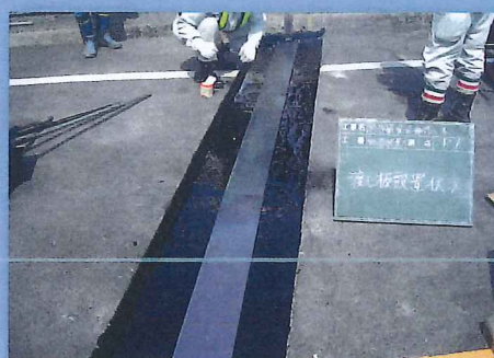
4 ギャッププレート設置
