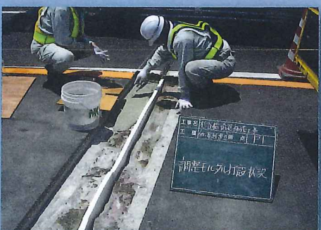
3 マイクロクラック補修工
